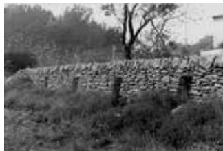
Mur à ruchers à Ventabren (Bouches-du-Rhône) © CERAV
